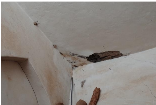
تصدعات الخرسانة المسلحة المستحدثة في سقف الجامع
